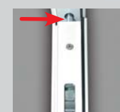
2 verrous à aiguille encastrés dans le semi-fixe
