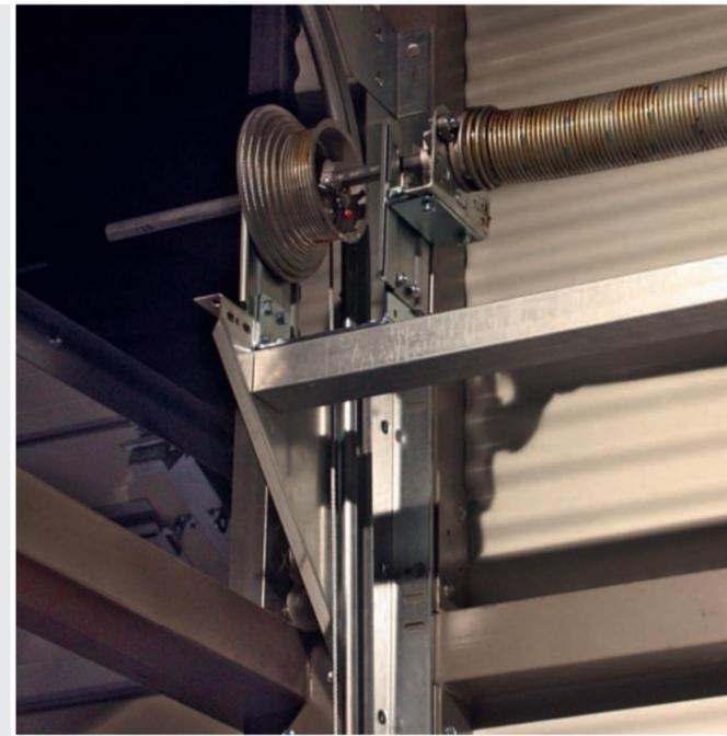
Grâce au système S, axe ressorts abaissé, le montage et l'entretien sont facilités, par sa position située juste au-dessus de l'ouverture.
